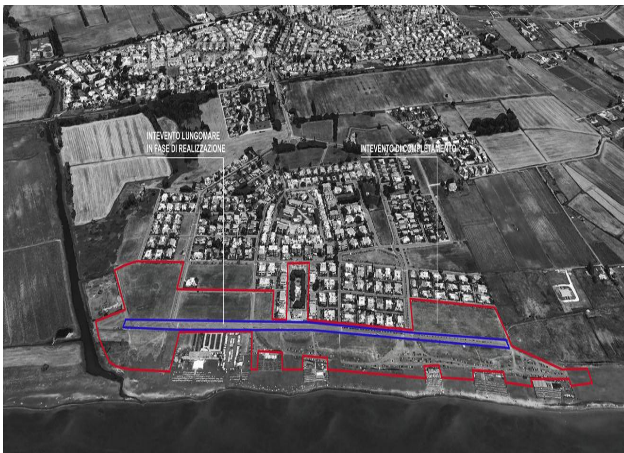
Vista dall'alto dell'intervento nel suo complesso
