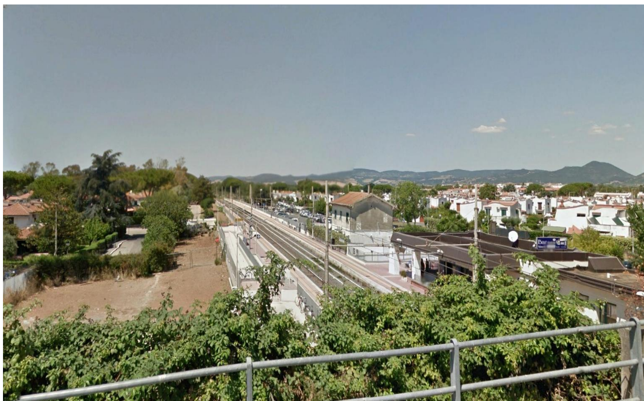
La Linea ferroviaria Roma-Civitavecchia e la stazione di Marina di Cerveteri
